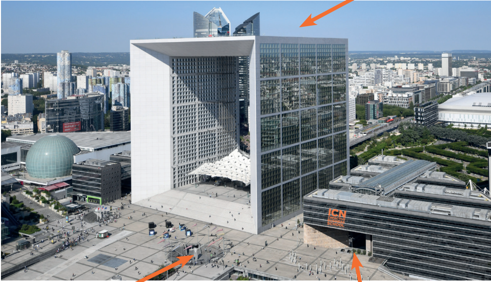
La Défense Grande Arche Metro Station
